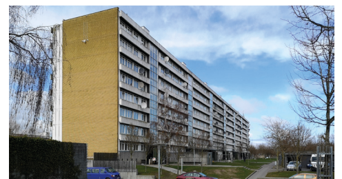
Indgangsfacaderne mod øst i parkerne mod Vollsmose Allé er udført med hvide fremtrædende betonbrystninger og tilbagetrukkede horisontale vinduesbånd, der efterfølgende er blevet opdelt af lodrette glasbånd.
