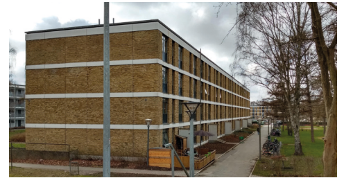
Indgangsfacader og gavle i parkerne mod Åsumvej er udført i mursten med hvide betonbånd, der markerer etageadskillelserne. Gavlene er mange steder efterisoleret med inddækning i gule tegl.
