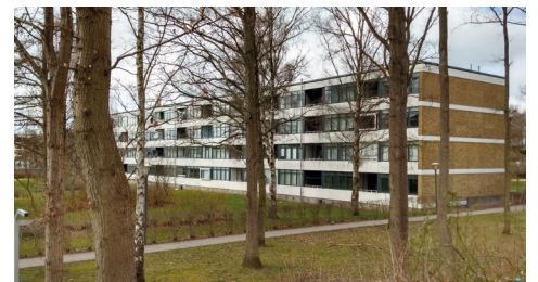
Altanfacaderne i parkerne mod Åsumvej er udført med hvide betonbrystninger og horisontale vinduesbånd, der veksler med indeliggende altaner. Brystningerne er sammenhængende med gavlens betonbånd, der markerer etageadskillelserne.
