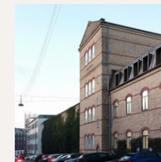
Figur 39: Foto af den undersøgte bygning
